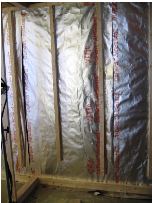
Figur 20 Varmereflekterende, inntrukket dampsperrer Teknisk Godkjenning 20004 Air Guard
