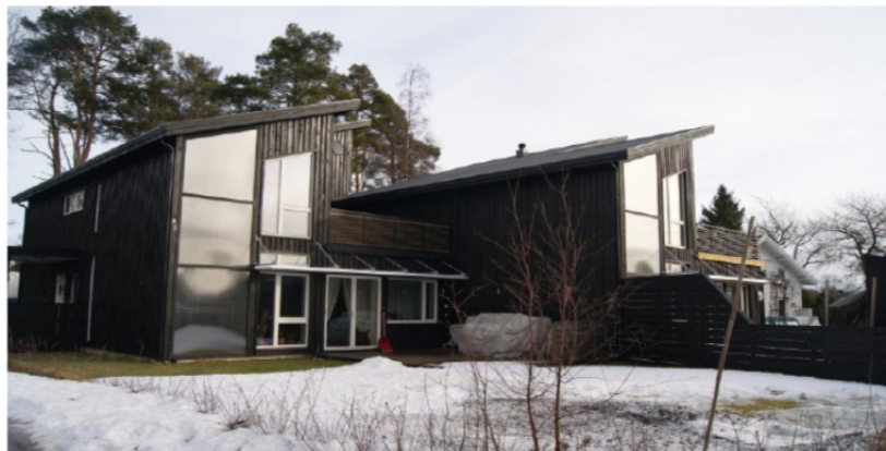
Figur 6.5.1 Til venstre (vest): Hus A med balansert ventilasjon. Til høyre (øst): Hus B med naturlig ventilasjon. Begge med solfangere til venstre på gavlfasaden mot sør. Foto: Eivind Thorstvedt.
