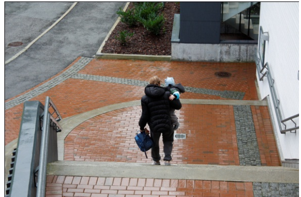
Trappen har jevn stigning og samme høyde på opptrinn, rekkverk på begge sider og i to høyder som følger hele trappeløpet, ledelinje i kontrast og markerte inntrinn, men ingen farefelt eller oppmeksomhetsfelt.
