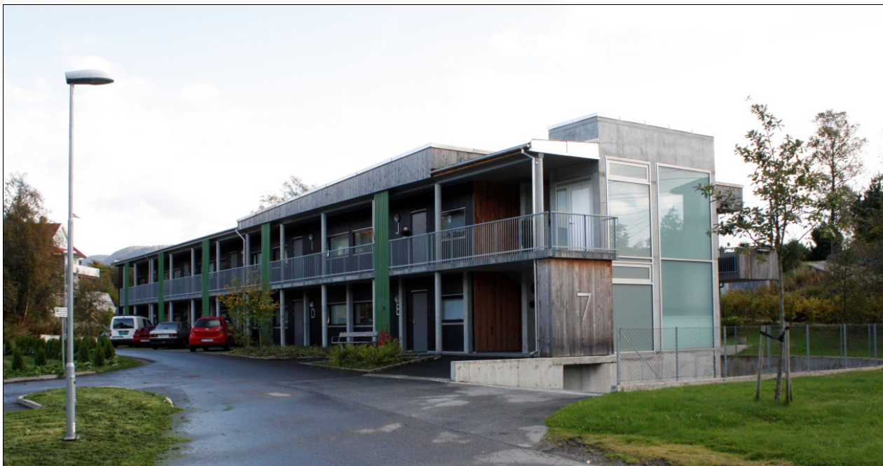
Husene har store godt synlige husnumre av stønset stål på fasadene mot veien.
