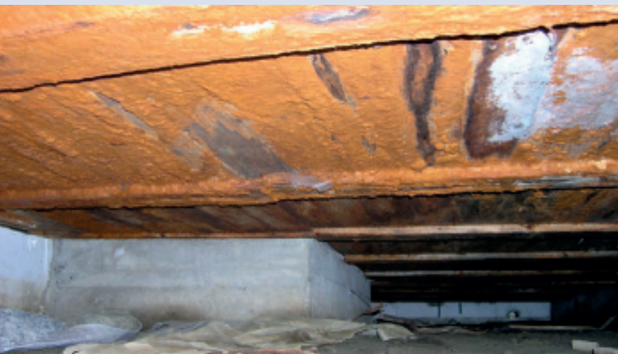
Råteskader i bjelkelag og stubblofts-bord. Foto: Byggforskserien 721.211.
