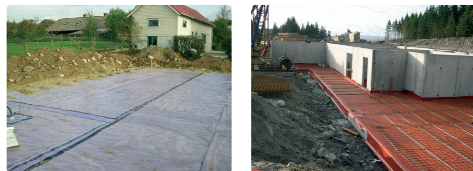
Fig. 1. Legging av radonmembran under (venstre) og over isolasjonen (høyre) under bygningens bunnplate.
