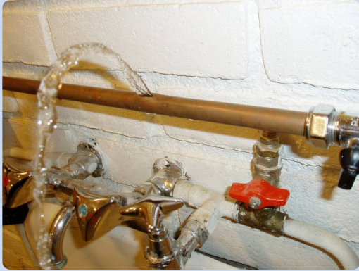
Frostsprengt kobberør
