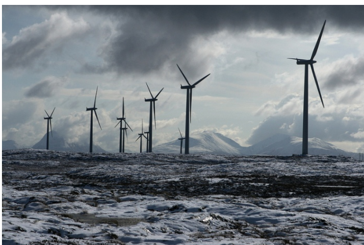
Smøla Vindpark Foto: Statkraft
