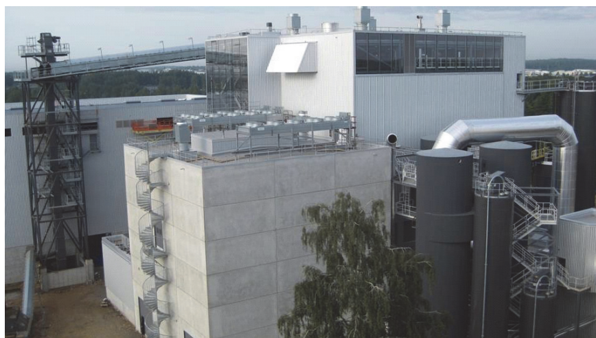
Figure 30: The Jordbro power plant. (photo: Vattenfall)
