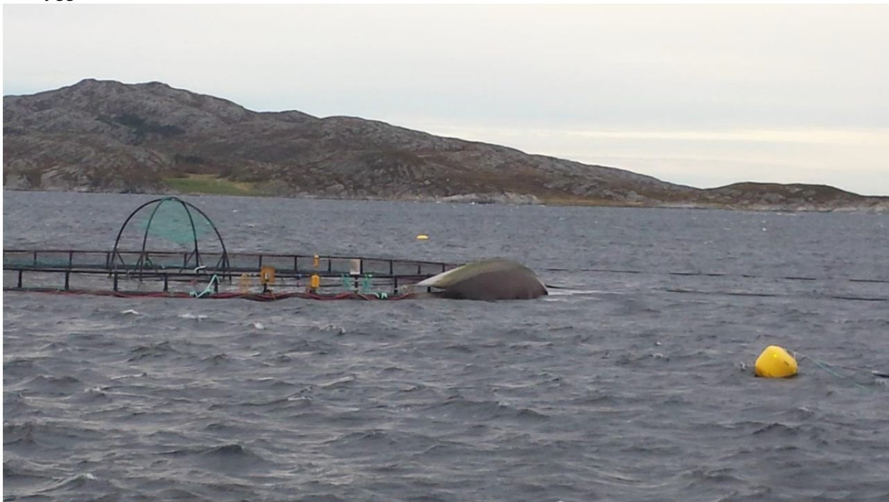
Figur 27. Skjørt kom opp av sjøen grunnet kraftig uvær.
