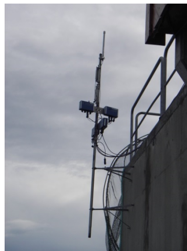
Antenne-systemer på et av anleggene i kartleggingen
