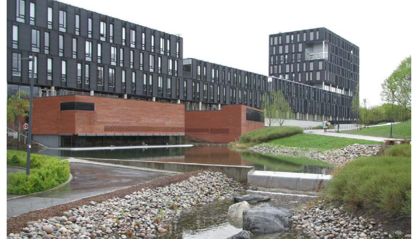
Vann kombinert med grønne løsninger og rekreasjon kan være et element i helhetlig behandling av overvann. Foto: Tore Kvande, NTNU
