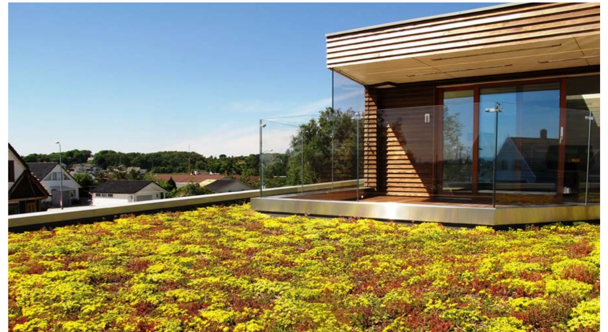
Sedumtak. Foto: Bergknapp
