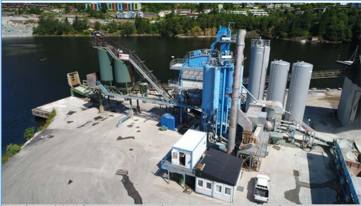
Veidekke Industris asfaltfabrikk i Førde kan produsere asfalt med fjordvarme hvis et nytt utviklingsprosjekt lykkes. Foto: Veidekke
